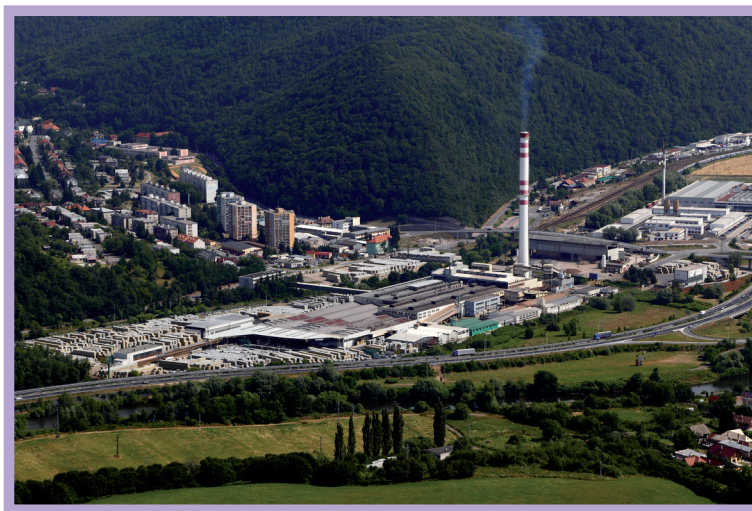
Výrobný závod Knauf Insulation Nová Baňa The production plant Knauf Insulation Nová Baňa
