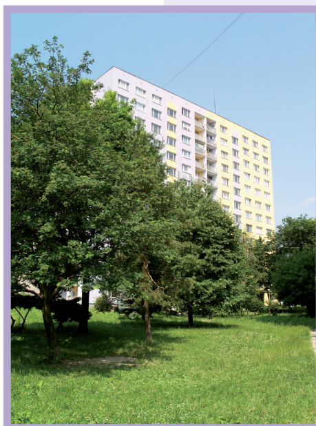
Zateplený panelový dom Insulated panel house
