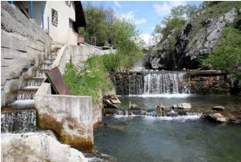
Obr. 7: Malé vodné elektrárne a kaskádovité stupne aj na menších vodných tokoch predstavujú priečnu bariéru pre ryby európskeho významu, napr. hlaváč bieloplutvý ( Cottus gobio ), foto: Peter Bačkor
