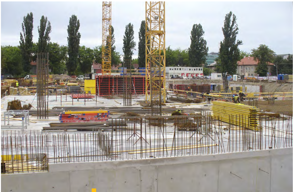
6 Výstavby polyfunkčného objektu KLINGERKA 2 – 3
