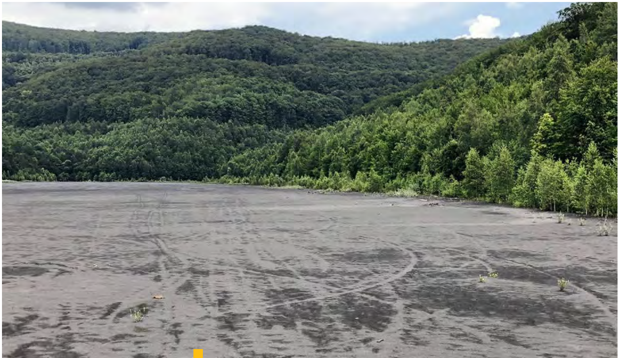
6 Pohľad na pláž odkaliska v Nižnej Slanej v okrese Rožňava, ktoré slúžilo na ukládanie banského odpadu z bane Siderit. Ide o environmentálnu záťaž evidovanú ako RV (010) / Nižná Slaná – banský závod a okolie – SK/EZ/RV/784. Na skládke sa podľa odhadov nachádza 5,5 milióna kubických metrov nebezpečného odpadu, júl 2020 (Zdroj: https://www.facebook.com/photo/?fbid=3104699796251452&set=a.219785170175057 – facebook MŽP SR)
