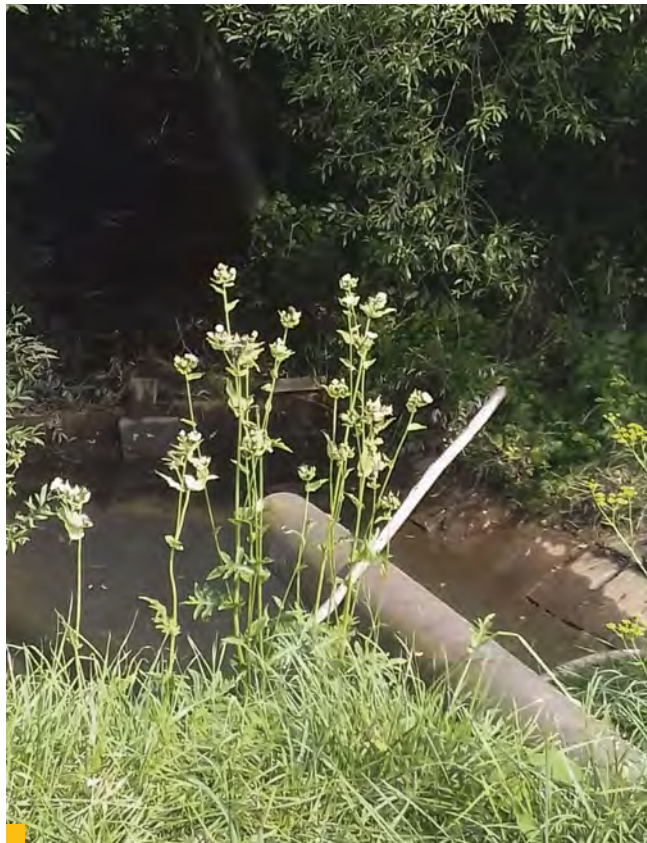
2 Odkalisko Rosina – pohľad na vyústenie havarijného prípadu čerpacej stanice odkaliska do Bytčického potoka
