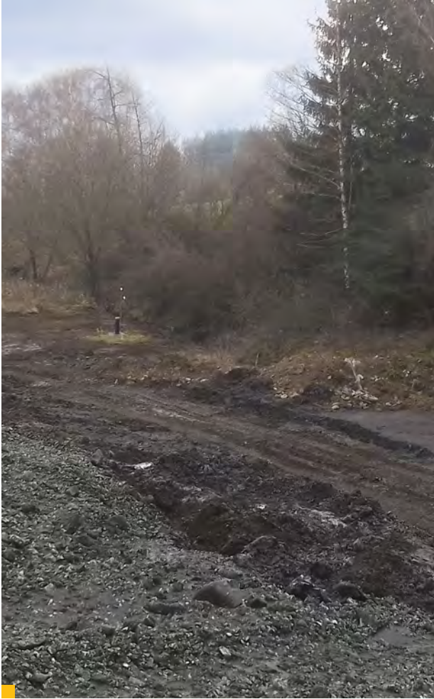
4 Skládka Široká – zeminou provizórne prehradený obvodový rigol
