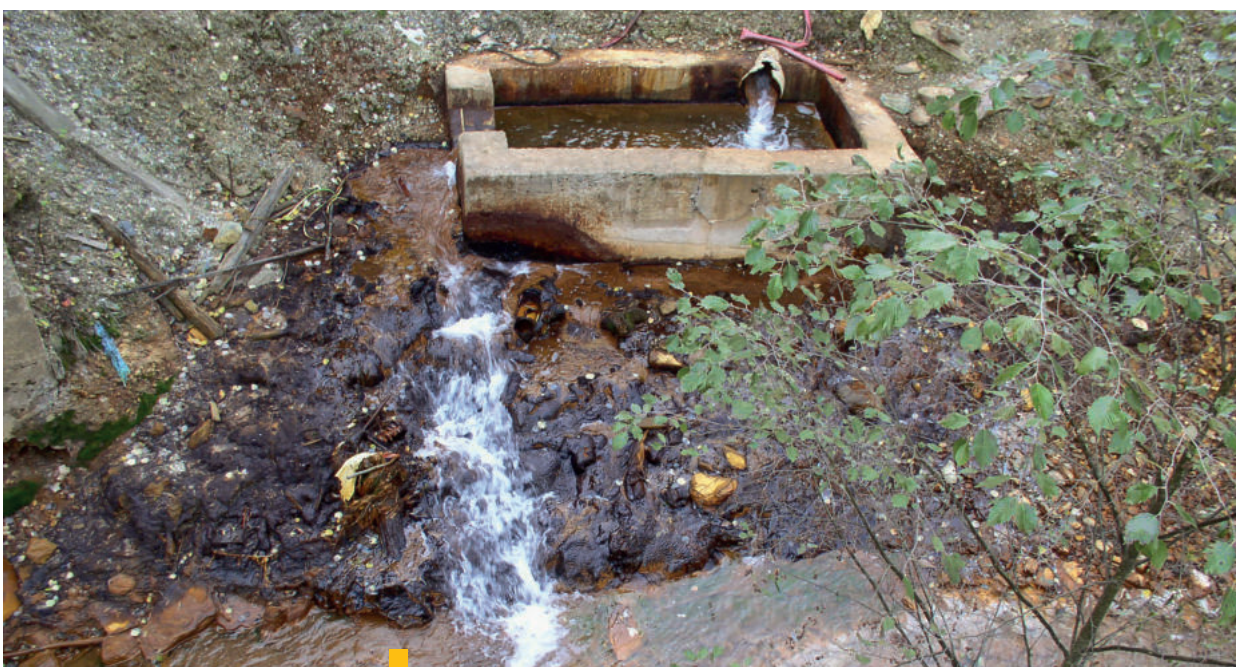
3 Drenáž šachty Péch privádzajúca banské vody do potoka Smolník. Drenážny kanál odvádzajúci vody z telesa odkaliska v Smolnickej Hute foto: Archív PRIF UK Bratislava
