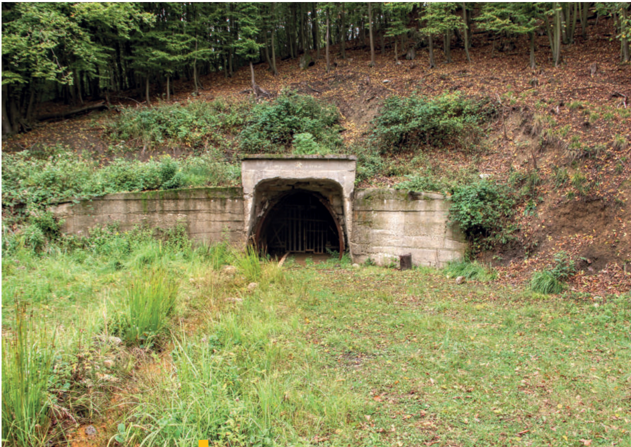
8 Pezinok – Kolársky vrch – lokalita antimónových a pyritových baní so štôľňou s výtokom sulfidických banských vôd s vyzrážanými okrami
