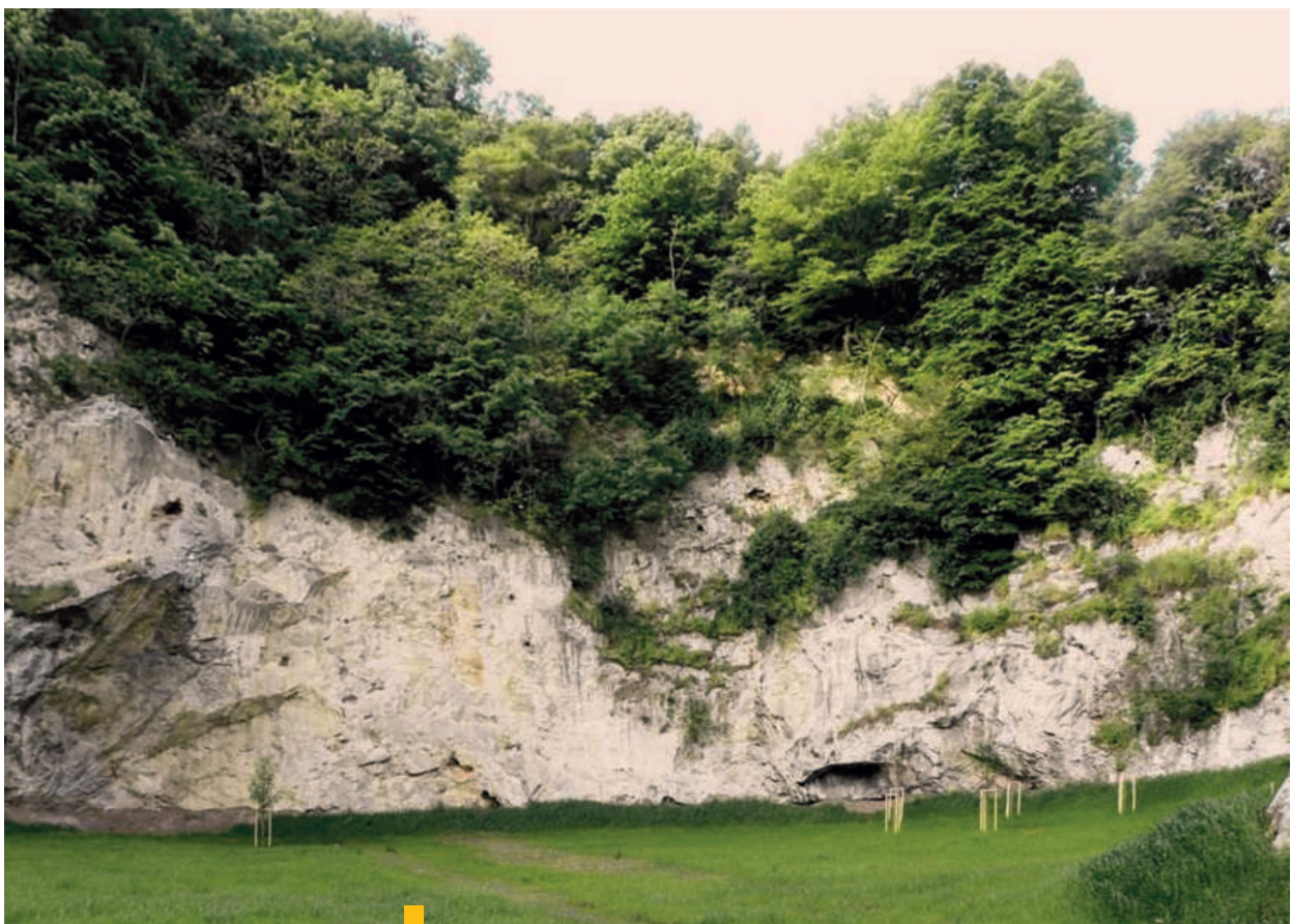
3 Obr. č. 1, 2, 3 Environmentálna záťaž v kameňolome Srdce v Devinskej Novej Vsi tesne pred sanáciou, počas nej a po ukončení sanačných prác foto: ENVIRONCENTRUM, s. r. o., Košice
