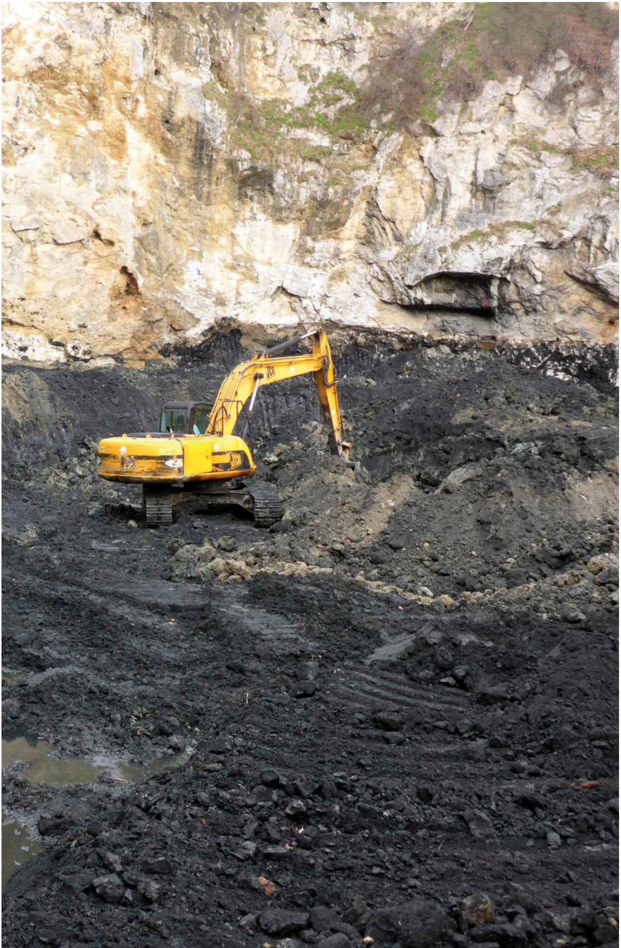
Sanácia EZ v kameňolome Srdce | foto: ENVIRONCENTRUM, s. r. o., Košice
