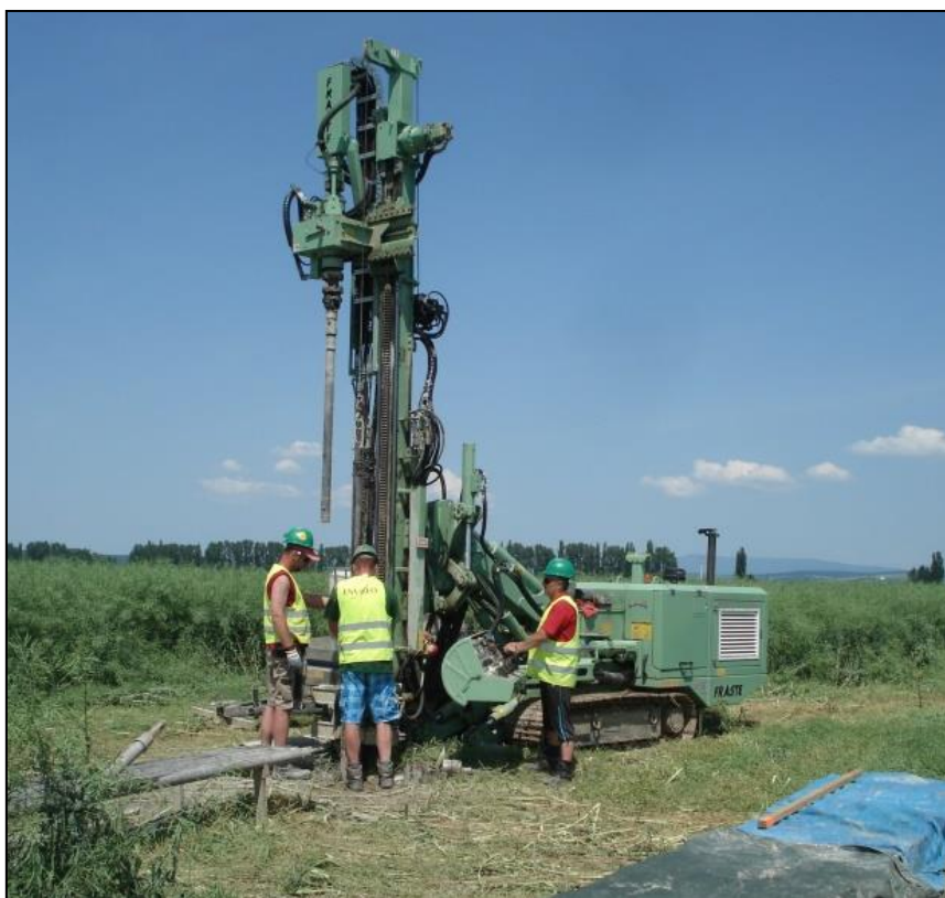
Obrázok 4. Hydraulicky ovládaná lafetová vrtná súprava na pásovom podvozku pri realizácii prieskumného jadrového vrtu
