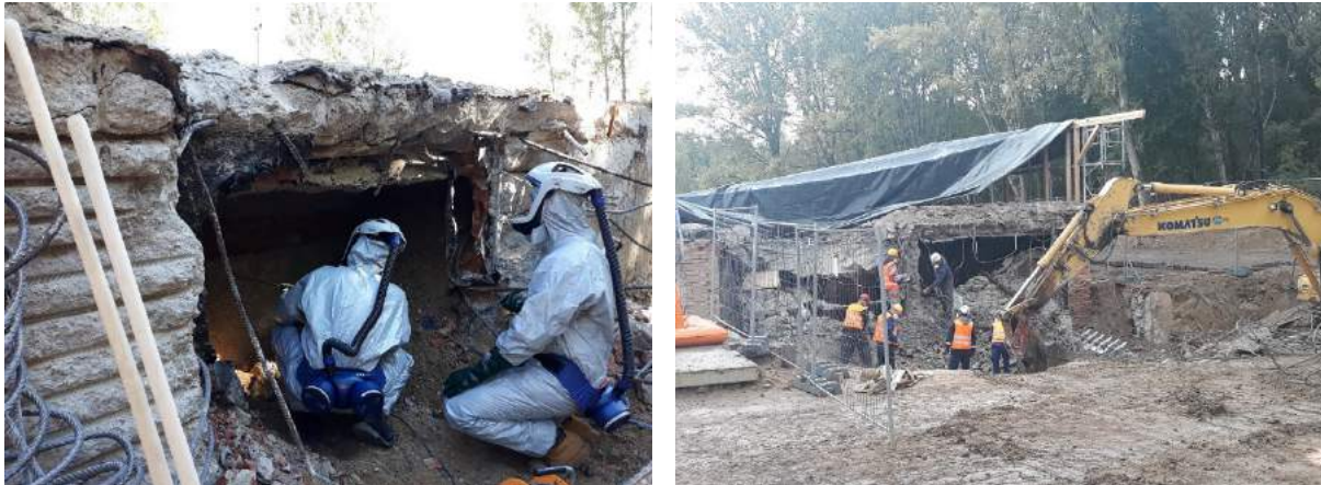
Obr. 3: Úvodní rekognoskace úložiště a demolice betonového úložiště
