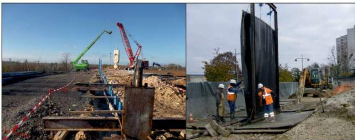
Obr. 1 – Nepriepustné bariéry – zhotovovanie tesniacich podzemných stien (foto archív Menard)
