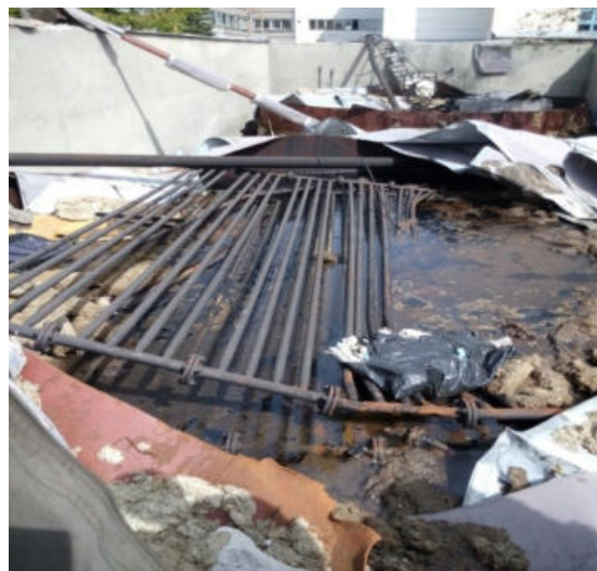
Obr. 9: Bývalé nádrže na mazut
