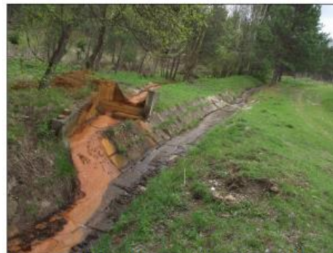
Obr. č. 29: Vrchná výúst drenážnej vody z odkaliska
