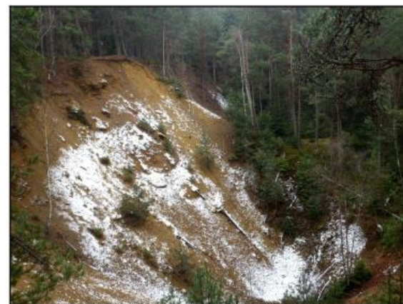
Obr. č. 57 Rozsiahle závalové pásmo v halde nad starým banským závodom
