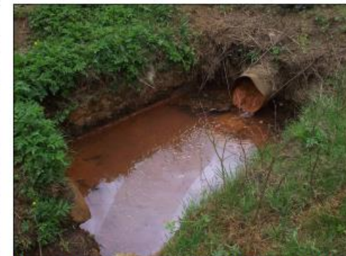
Obr. č. 30: Spodná výúst drenážnej vody z odkaliska
